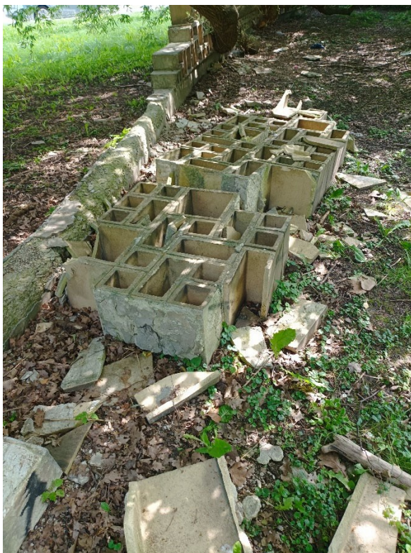
Niekoľko metrov plotu má ešte zachovanú aspoň časť tvárnic, často rozpraskaných alebo zlomených (vľavo), ale na niekoľkých metroch sa zachovali už len pozostatky rozdreného základu (vpravo).
