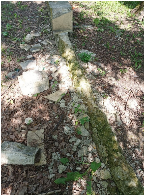
Niekoľko metrov plotu má ešte zachovanú aspoň časť tvárnic, často rozpraskaných alebo zlomených (vľavo), ale na niekoľkých metroch sa zachovali už len pozostatky rozdreného základu (vpravo).
