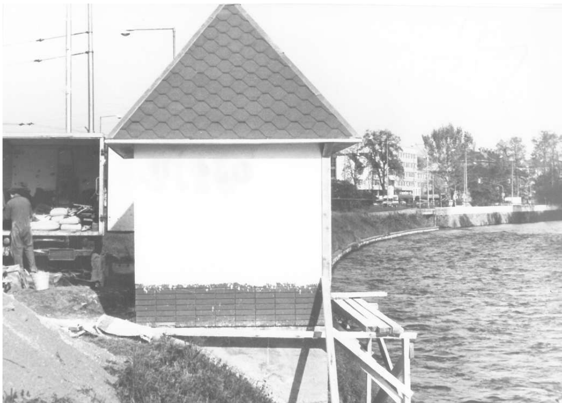
Výstavba murovanej vodomernej stanice na Hrone v roku 1994 - archív SHMÚ Banská Bystrica
